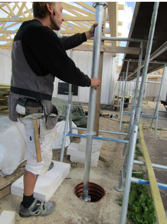
Eksempel på søjle til nedstøbning.
